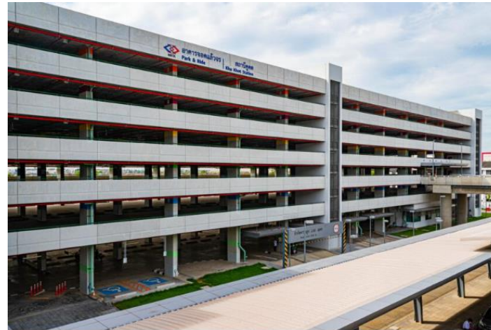
อาคารจอดรถ รถไฟฟ้าสายสีม่วง ที่ท่า
