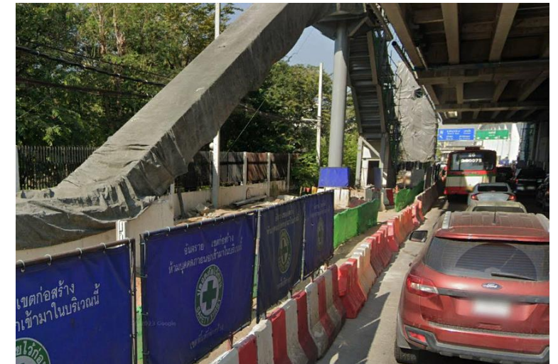
ติดตั้งป้ายจราจร ป้ายเตือน ไฟฟ้าส่องสว่าง
