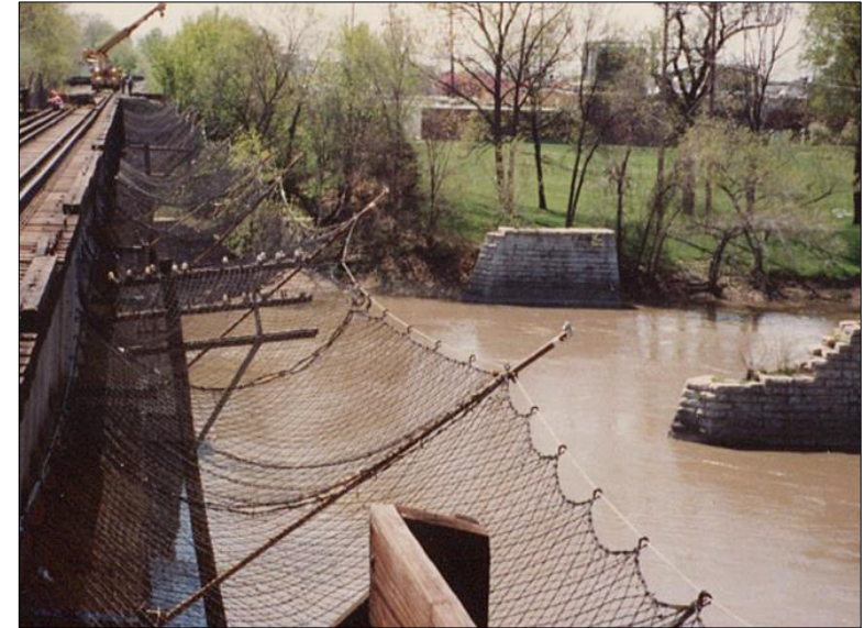
ติดตั้งตาข่าย (safety Net)
